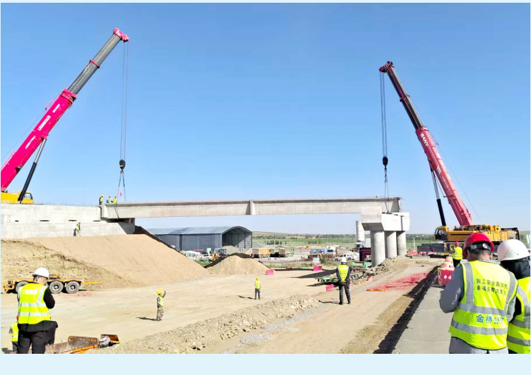
▲国道209线南互通箱梁吊装顺利,实现全幅贯通。
