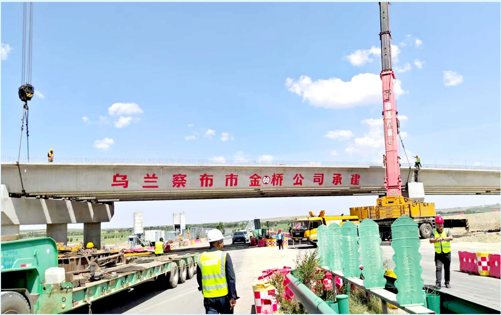
▲国道209线南互通箱梁吊装顺利,实现全幅贯通。
