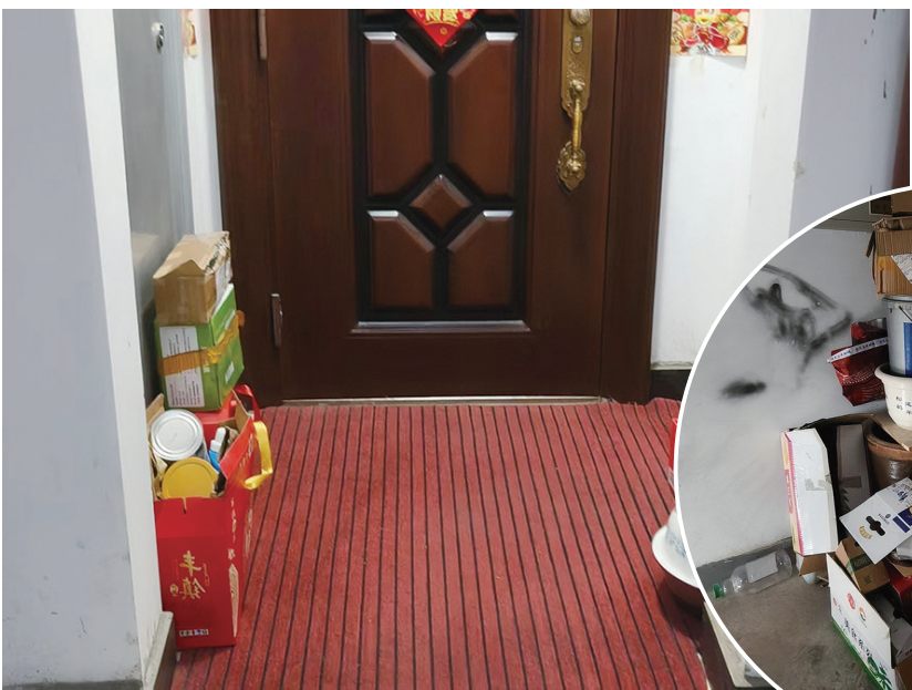
●楼道内堆积的杂物
